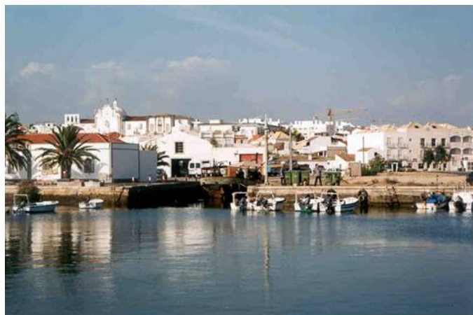
Fotografia 4.11.2 – Cais de acostagem da margem esquerda do Rio Gilão
