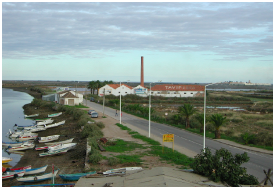
Fotografia 2.4.3 – Deposição de entulhos na área de estudo (Outubro de 2002)
