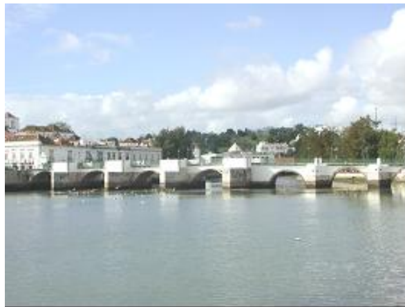
Fotografia 4.10.2 – Ponte antiga sobre o rio Gilão
